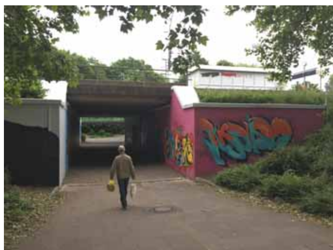
Zugang von Westen
