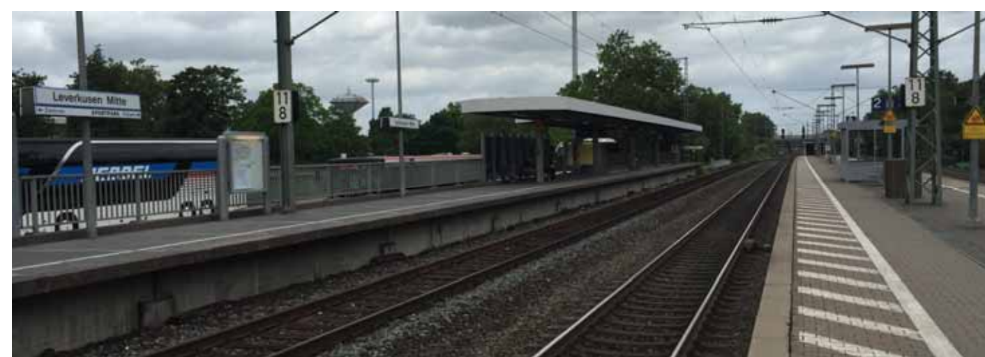
Blick von Gleis 2 zu Gleis 1
